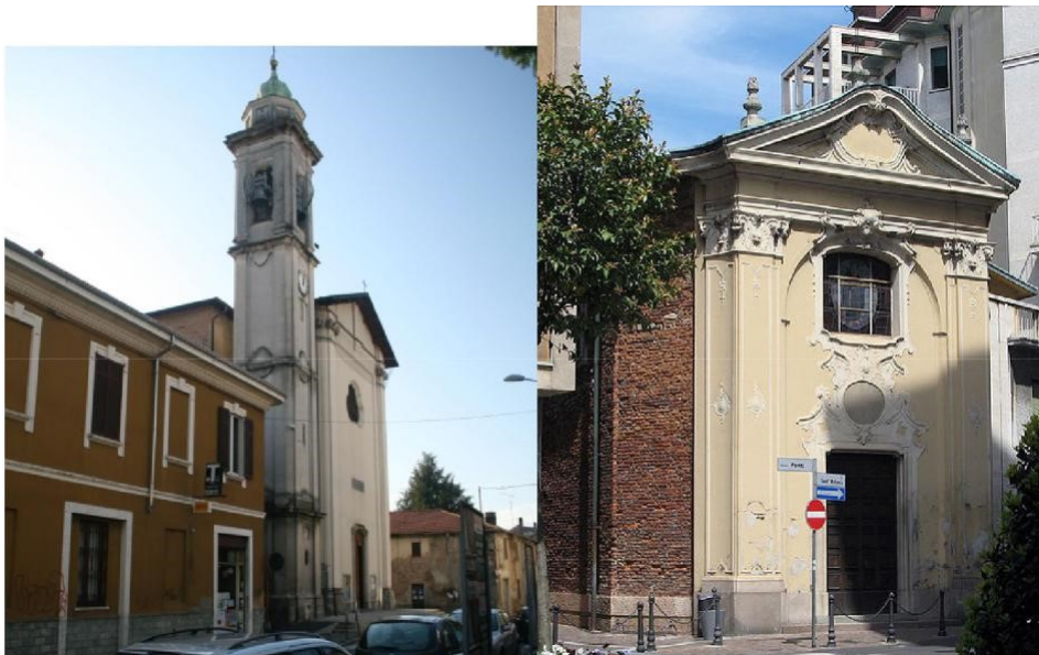
Figura 6 – La Chiesa di S. Giorgio e la Chiesa di Sant'Antonio abate
