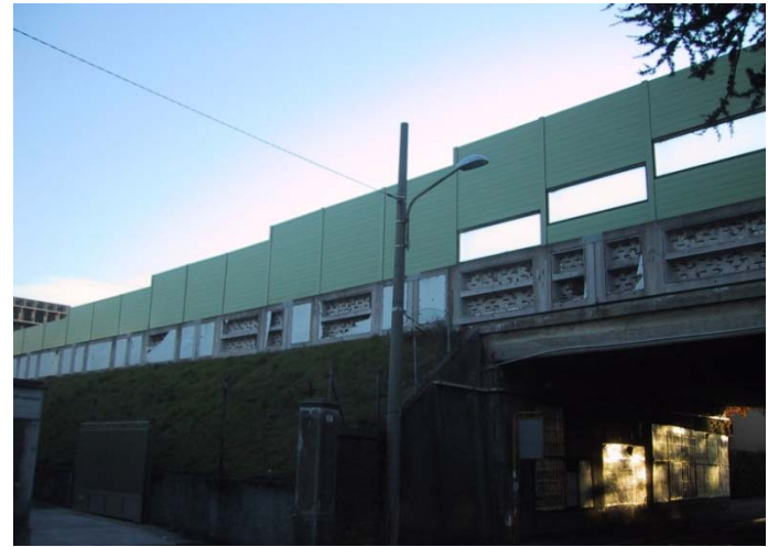
Barriere di contenimento delle emissioni acustiche della A8 nell'attraversamento dell'abitato di Gallarate
