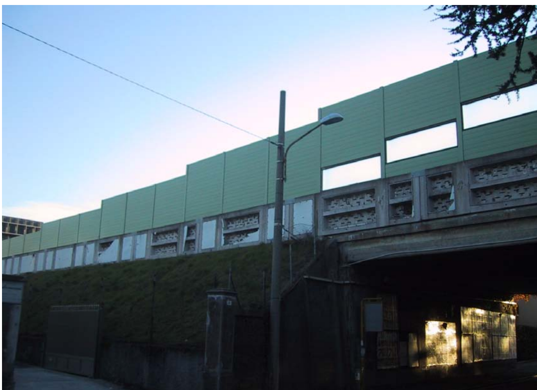
Barriere di contenimento delle emissioni acustiche della A8 nell'attraversamento dell'abitato di Gallarate
