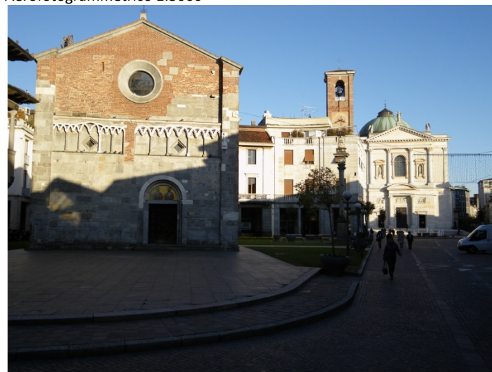
La facciata principale
