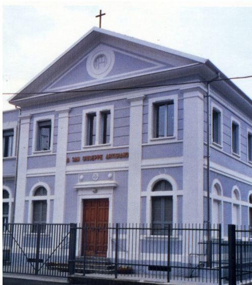
La facciata principale
