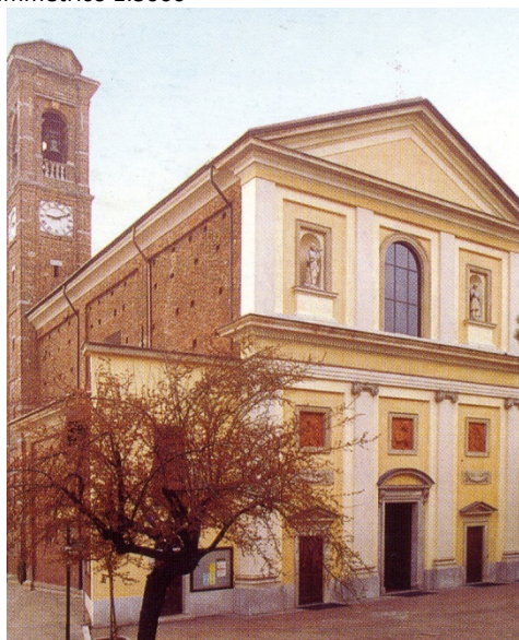
La facciata principale
