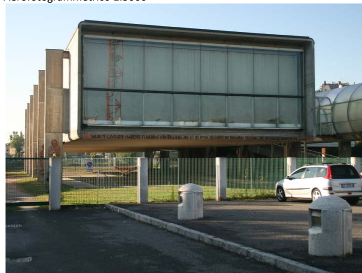
La facciata principale
