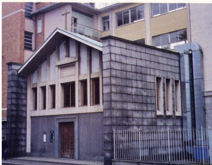
La facciata principale
