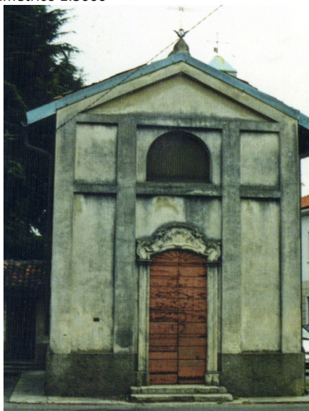
La facciata principale
