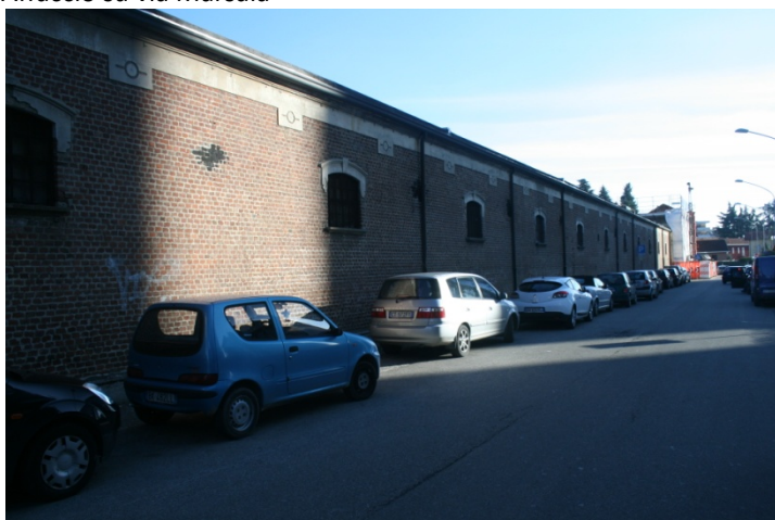
Ingresso da Via Mentana
