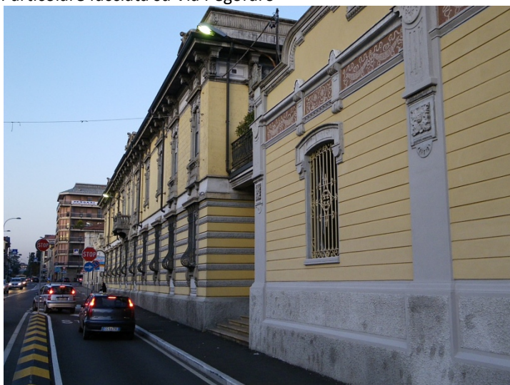
Particolare facciata su Via Pegoraro
