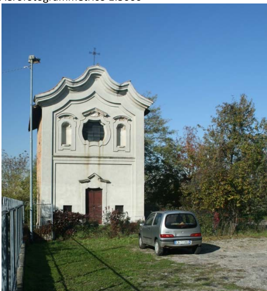
La facciata principale
