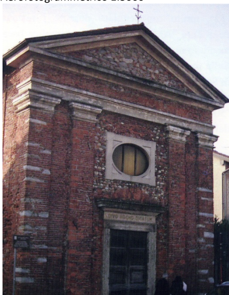
La facciata principale
