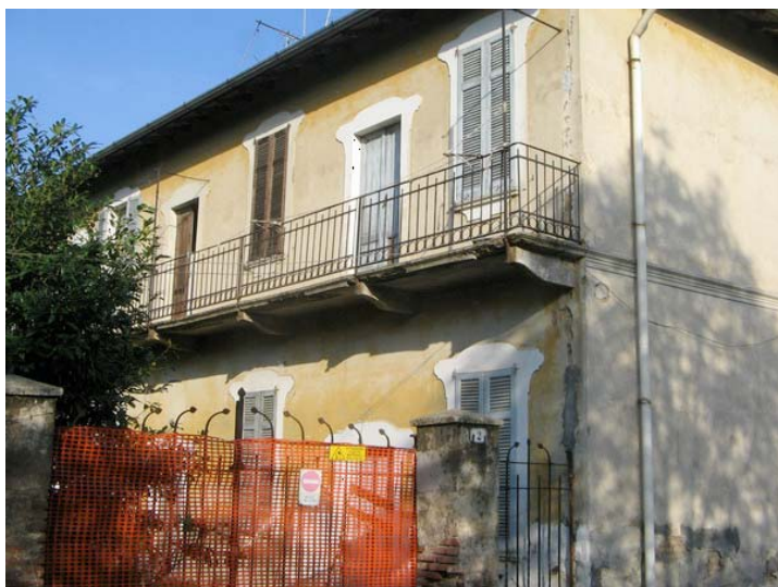
Particolare della facciata con ballatoio
