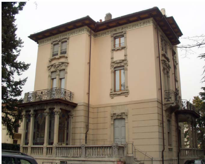
Affaccio su via Alighieri
