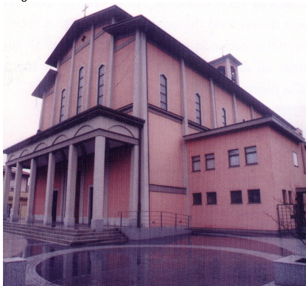
La facciata principale
