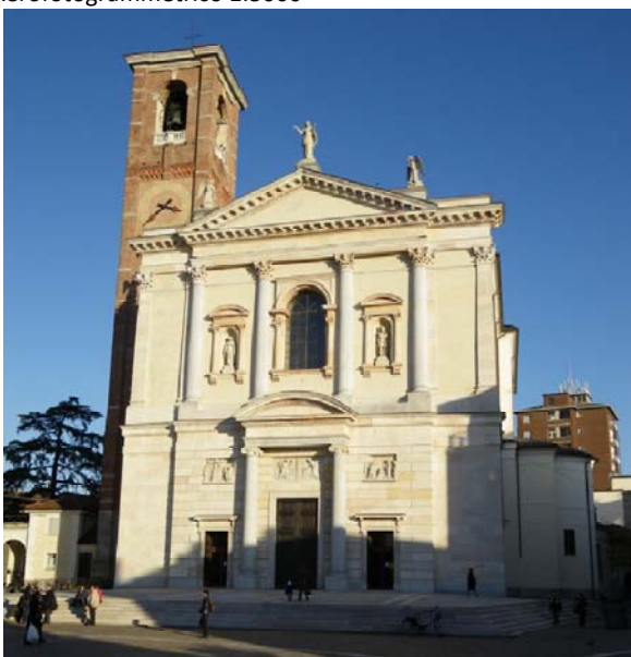
La facciata principale
