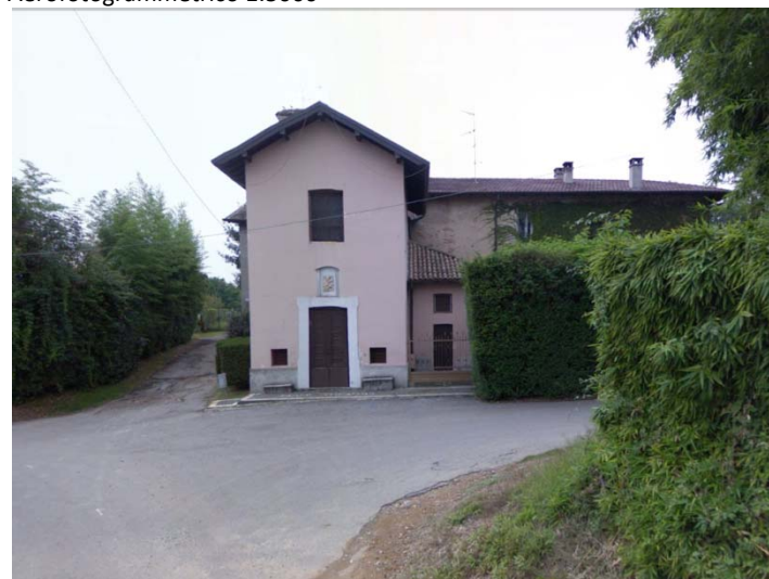
L'oratorio del complesso cascinale su via Montello
