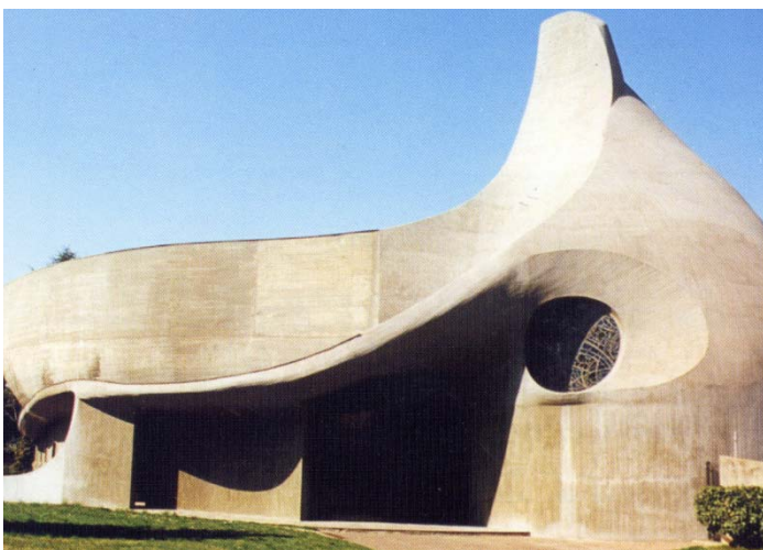
La facciata principale
