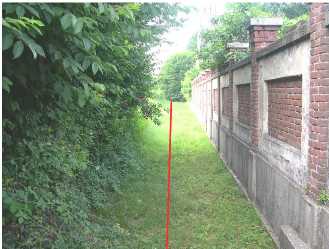
Fig. 1.2.4: Foto 1.2.4 – Colatore dei Prati
