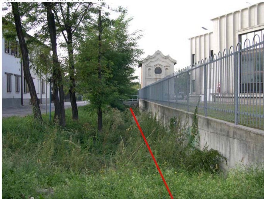
Fig. 1.2.10: Foto 1.2.10 – Colatore dei Prati
