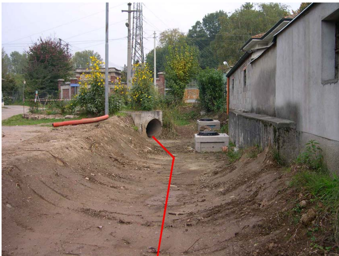
Fig. 1.2.6: Foto 1.2.6 – Colatore dei Prati
