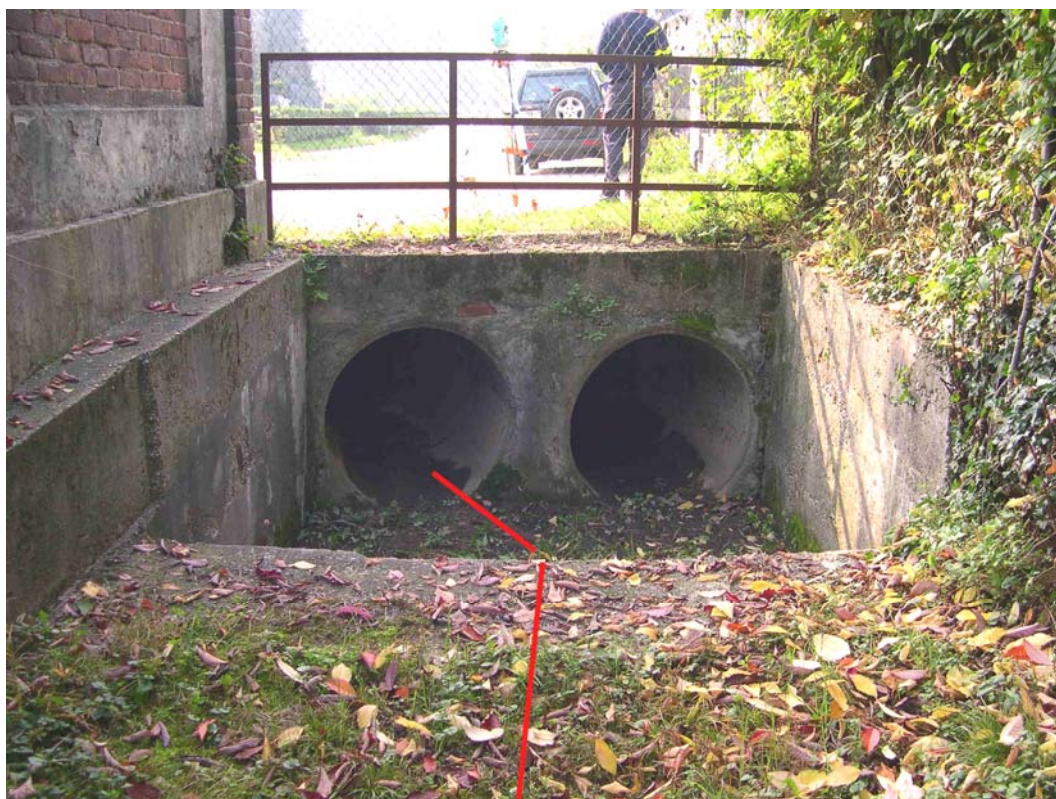
Fig. 1.2.5: Foto 1.2.5 – Colatore dei Prati
