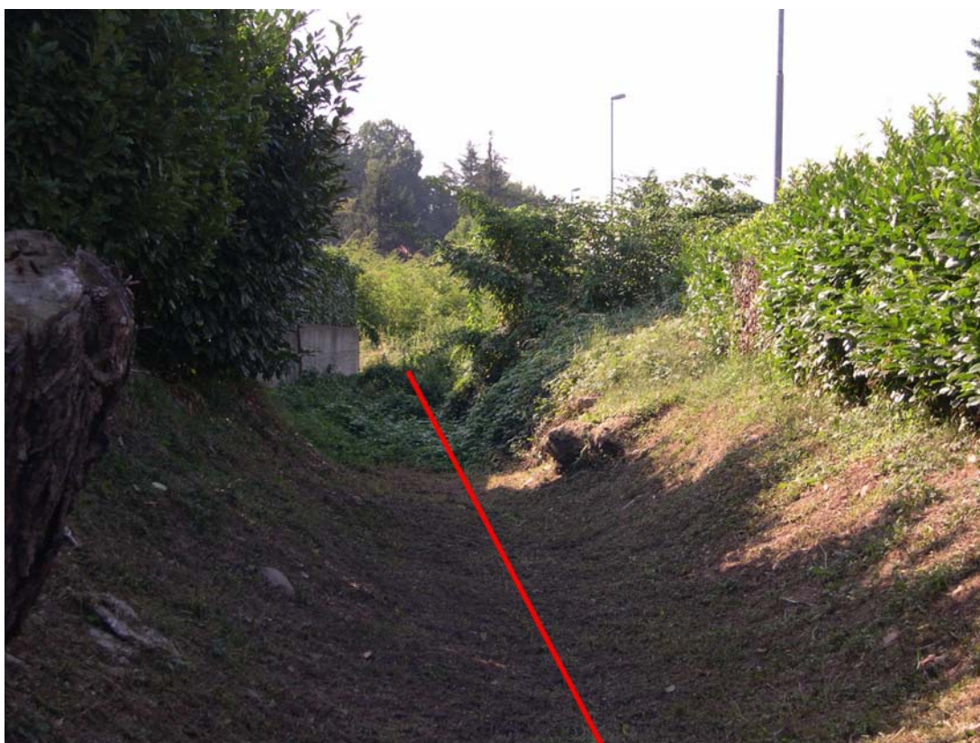
Fig. 1.2.7: Foto 1.2.7 – Colatore dei Prati
