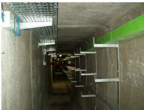
Esempio di galleria a sezione rettangolare attrezzata con le staffe per la posa delle reti
