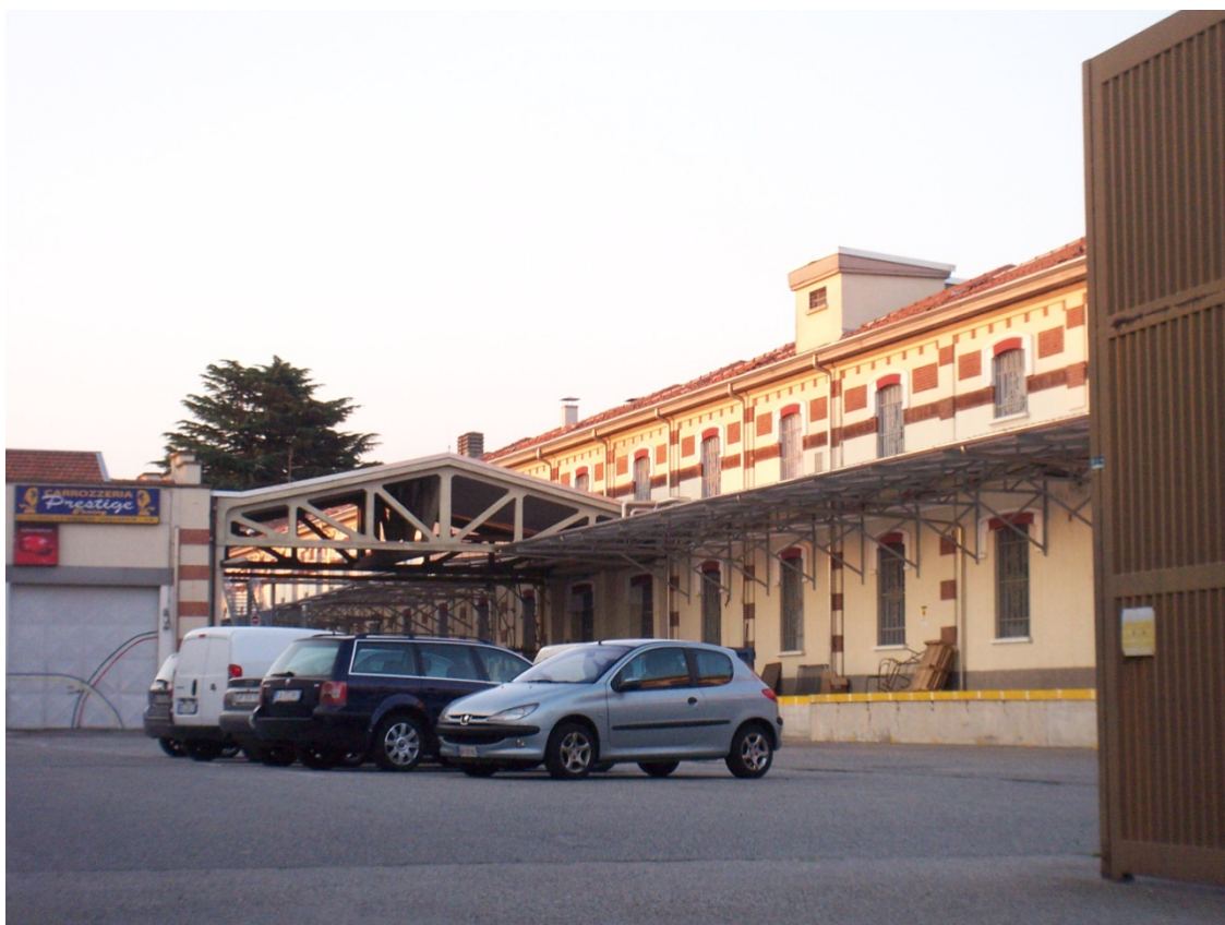
Figura 28 – Vista interna del Cottonificio F.lli Bellora
